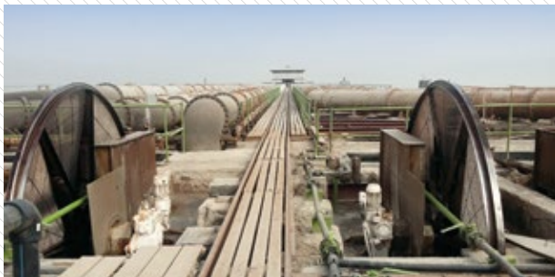
Gaskraftwerk Shuwaikh Power Plant, Kuwait Engineering Erdungsanlage Umsetzung: 2015
