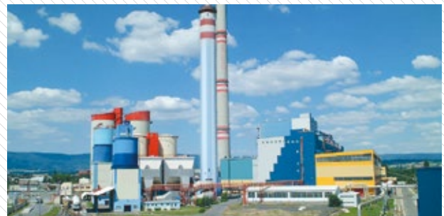
Kohlekraftwerk Ledvice, Tschechien Planung und Errichtung der Blitzschutzanlage Auftrag: 80.000 Euro / Umsetzung: 2013 - 2014
