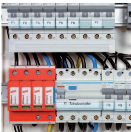
**Bild 3.** Anschlussfertiger Ableiter Typ 2 „Dehn-Guard M TT“ für das TT-System
